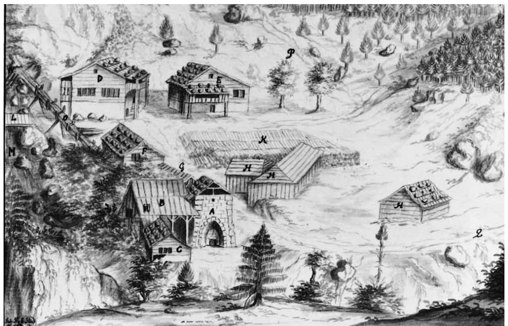
Abb. 13: Der «Prospect der Oberhaslischen Eysen Schmelze im Mülithal, von der Mittag Seiten anzusehen» von 1760 verzeichnet nicht nur anschaulich die Werksanlagen und das mächtige Stammholzlager, sondern auch ihre unentbehrlichen Verbindungswege: links die «Brug über den Gentelbach» (L), über welche die Erzeugnisse des Werks nach Westen ins Bernbiet geführt wurden, oben den «Ertz Weg» (P) aus dem Gental und rechts den «Kohl Weg» (Q) aus dem Gadmental. (STABE B V 941a: 310; Foto Staatsarchiv des Kantons Bern.)
