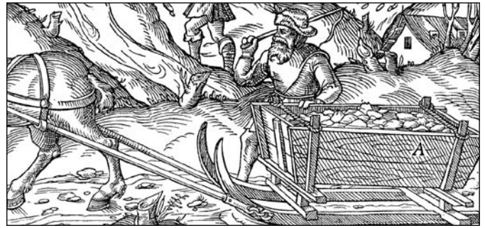
Abb. 14: Bereits das klassische Werk des sächsischen Humanisten Georg Agricola setzt sich anschaulich mit der Vielfalt der Transportmittel im Bergbau auseinander. (AGRICOLA G. 1961, 1977: Zwölf Bücher vom Berg- und Hüttenwesen. Reprints Düsseldorf, München [dtv 6086]: 137-142. Erstdrucke 1556 lateinisch, 1557 deutsch.)
